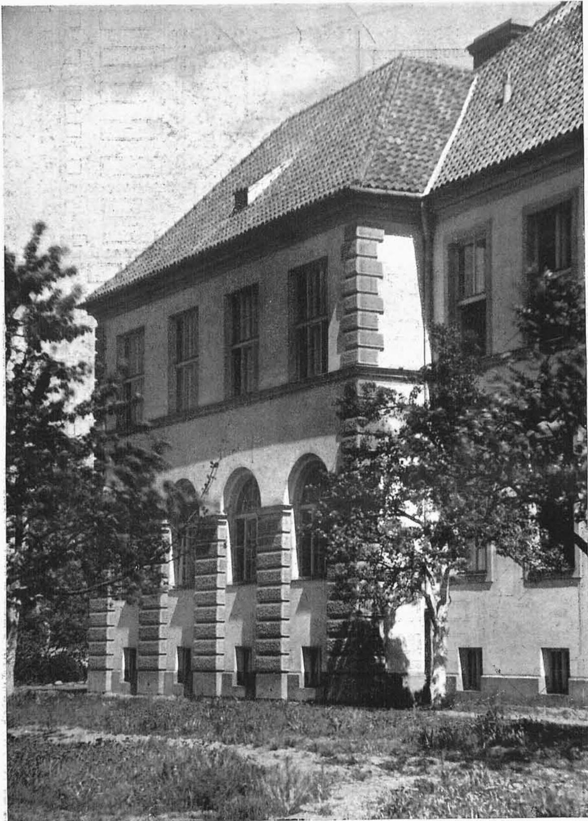
FRAGMENT FASADY OD STRONY ZACHODNIEJ.
