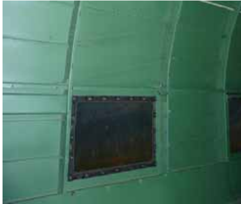
Rys. 13.32. Wykroj na okno w samolocie DC-3 ( Musée de l’Air et de l’Espace – Aéroport de Paris-Le Bourget )
