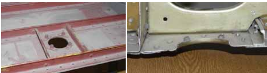
Rys. 12.30. Wzmocnienie niewielkich wykrojów dostępowych – przynitowanymi dublerami
