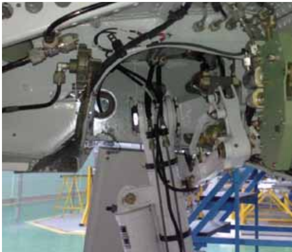
Rys. 12.66. Wprowadzenie sił skupionych od podwozia w ścianki dźwigara skrzynkowego w samolocie PZL-130 Orlik ( Airbus Polska/Piotr Jaśkowski )
