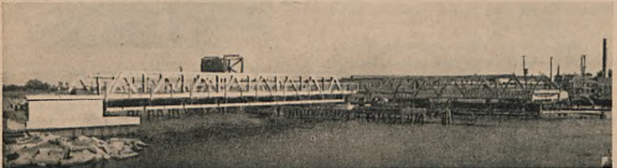
Rys. 1. Most Riverside-Delanco U. S. A. — ogólny widok mostu.
