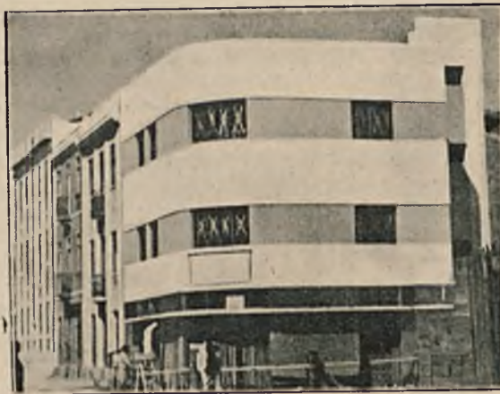
Rys. 2. Mały dom czynszowy o konstrukcji stalowo-szkieletowej. Budynek po ukończeniu.
