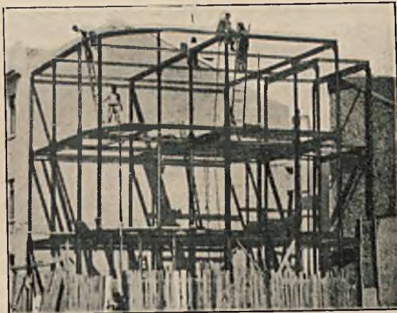
Rys. 1. Mały dom czynszowy o konstrukcji stalowo-szkieletowej. Montaż szkieletu stalowego.
