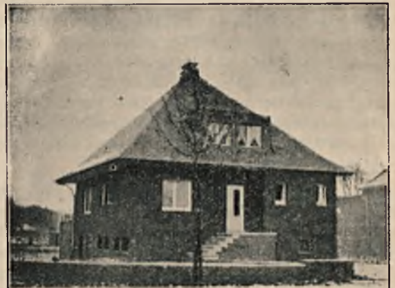
Rys. 4. Jednorodzinny dom mieszkalny o konstrukcji stalowo-szkieletowej i stalowej konstrukcji dachu — gotowy do użytku.
