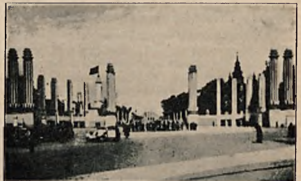
Rys. 2. Wejście „Entrée du Centenaire“.
