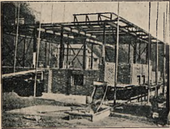
Rys. 1. Jednorodzinny dom mieszkalny w budowie. Obciążenia przenosi szkielet stalowy, mur stanowi jedynie wypełnienie oraz izolację termiczną i akustyczną.
