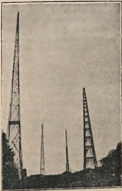
Rys. 2. Wieże radiostacji w Langenberg. Na lewo stare wieże o konstrukcji stalowej, na prawo wieża drewniana bezpośrednio po ustawieniu.
