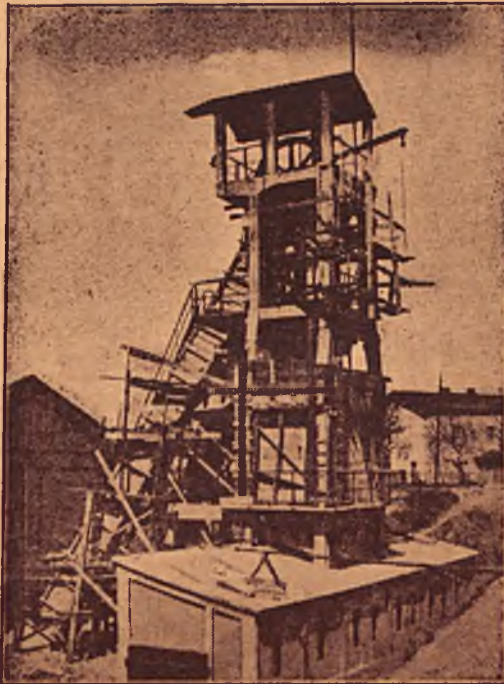
Wzmocnienie żelbetowej wieży wyciągowej dla zwiększonego o 80 % obciążenia dla szybu wschodniego KOPALNI DĘBIENSKO
