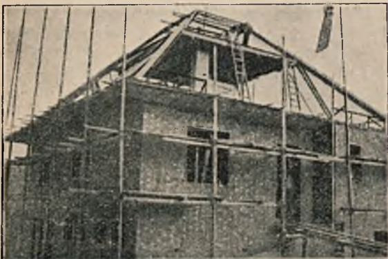
Rys. 2. Szkielet stalowy wypełniony ścianami, konstrukcja dachowa przygotowana do krycia.
