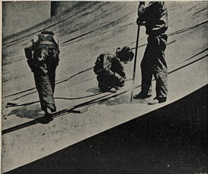
Rys. 5. Montowanie wierzchnich pasm blachy. Pasma oparte są na deseczkach, ułożonych na sąsiednich dolnych pasmach.
