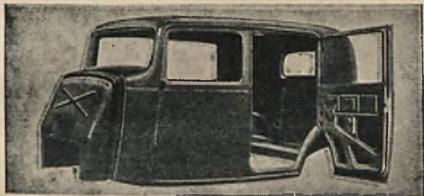
Rys. 7. Całkowicie stalowa skrzynia karoserji Citroën.
