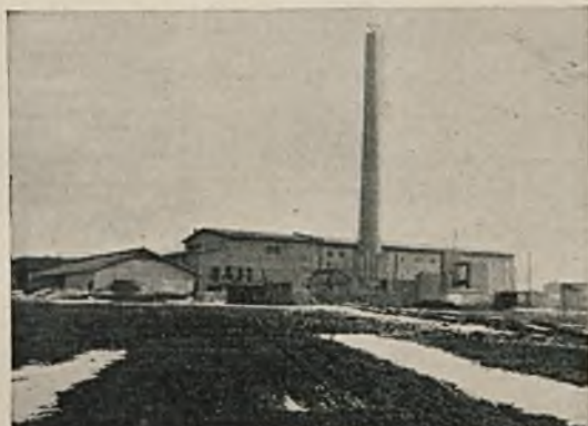
II. Kompletna budowa nowej cegielni dla Województwa Śląskiego Dom Pracy Przymusowej w Lipiu.
