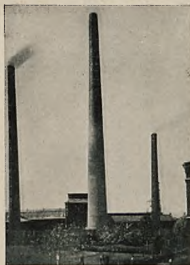
III. Kompletna budowa komina wysokości 105 m \times 3,50 \phi dla Grodzieckiego Towarzystwa Kopalń Węgla w Groźcu.
