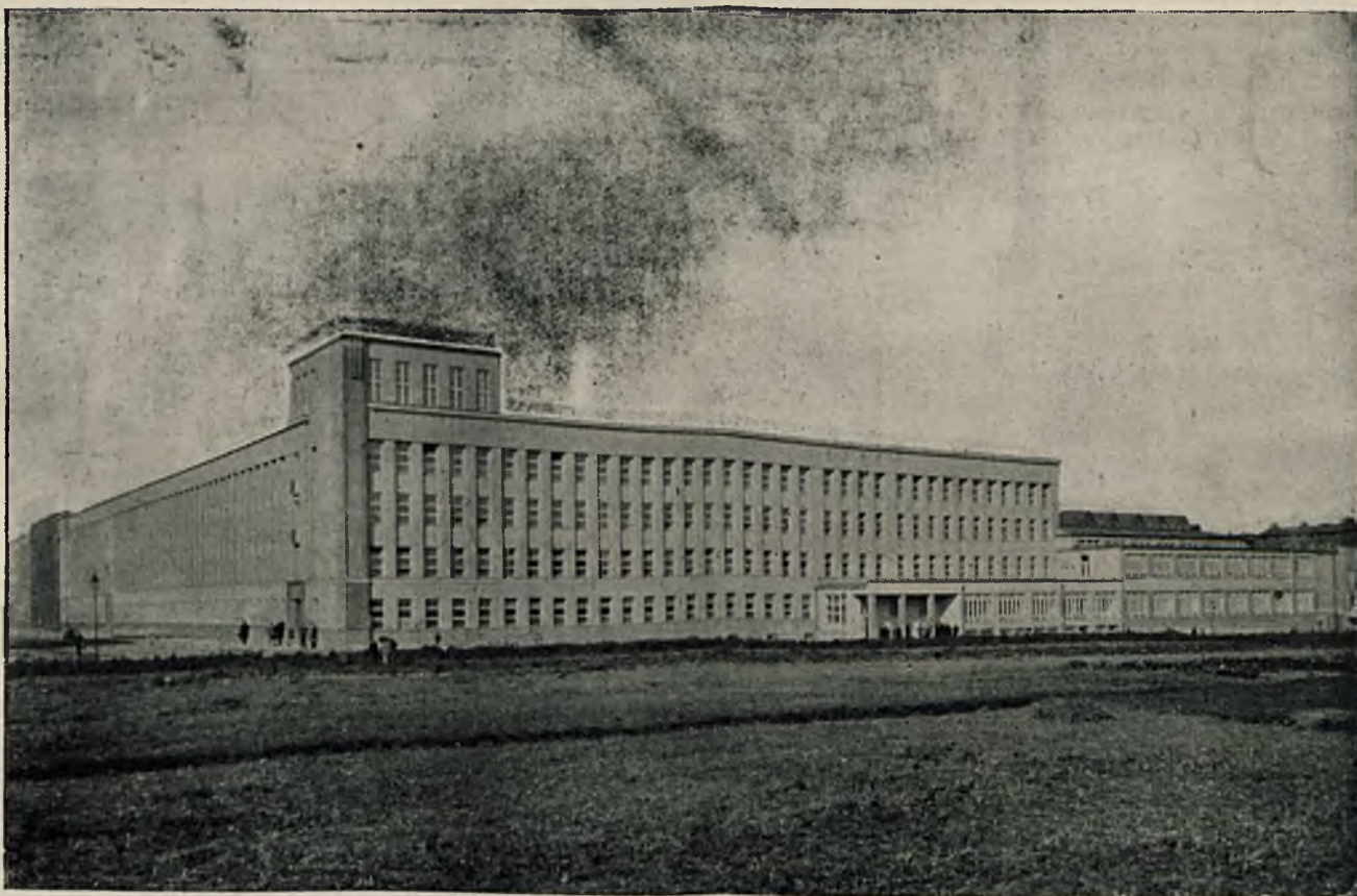
Gmach Śląskich Technicznych Zakładów Naukowych w Katowicach.
