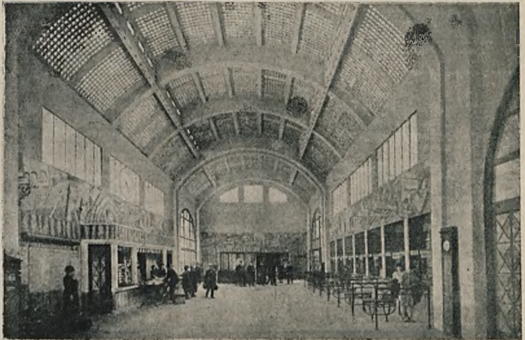
Rys. 4. Widok głównej hali dworcowej w Lens.
