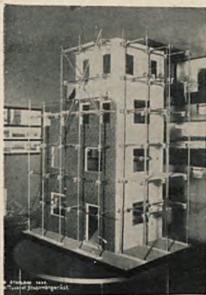
Model rusztowania budowlanego z rur na wystawie w Lipsku.
