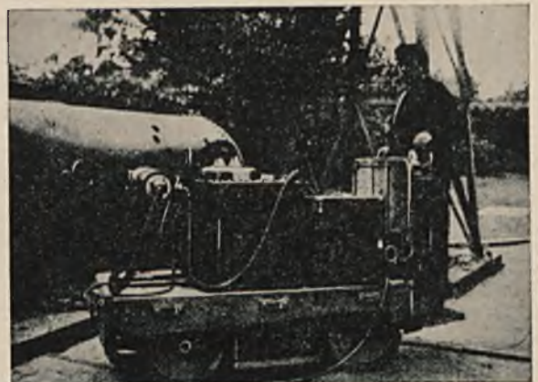
Rys. 14. Instalacje do badania promieniami Roentgena przewożone na wózku elektrycznym.
