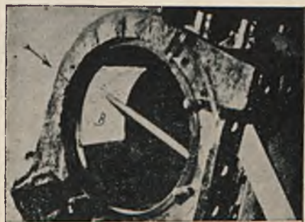
Rys. 6. Umieszczenie kasety B w cylindrze do prześwietlania promieniami Roentgena.
