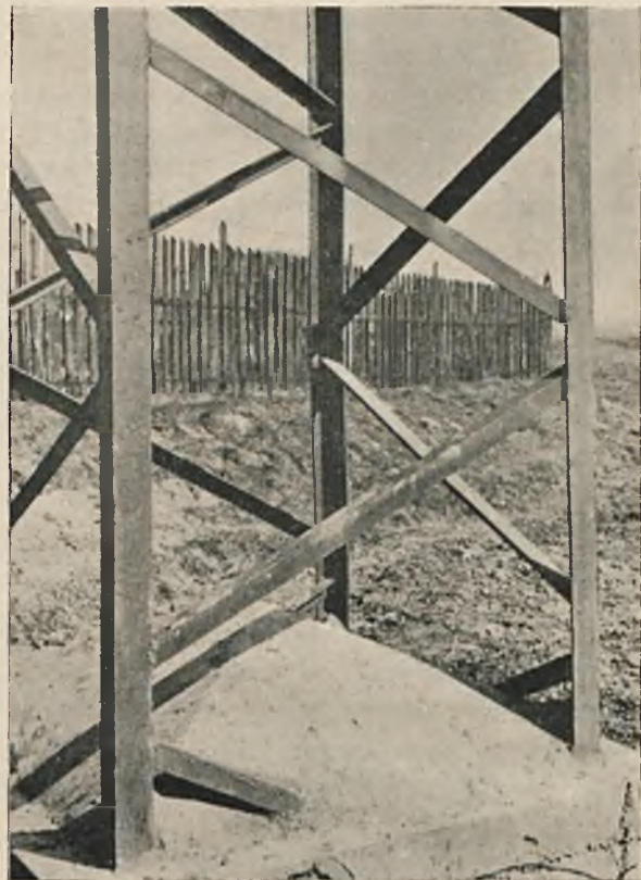
Rys. 5. Szczegół spawanego słupa.
