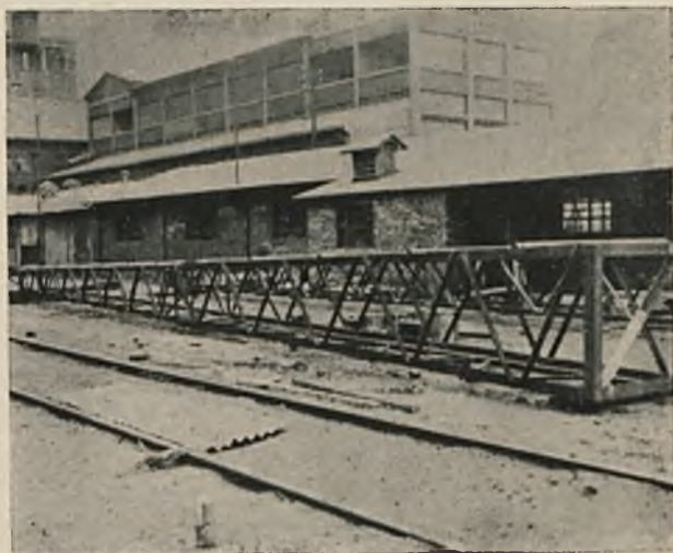
Rys. 6. Słup spawany po wykonaniu.
