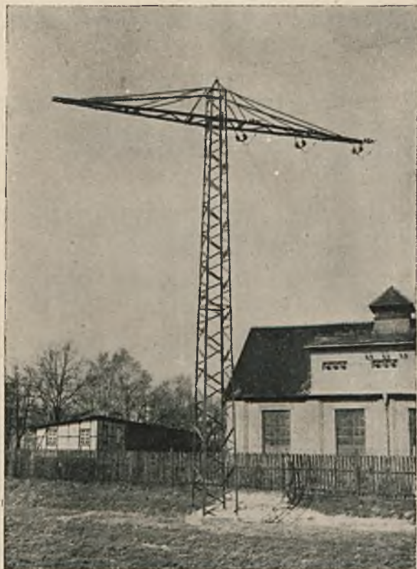
Rys. 4. Spawany słup elektryczny przy centrali w Pszczynie.
