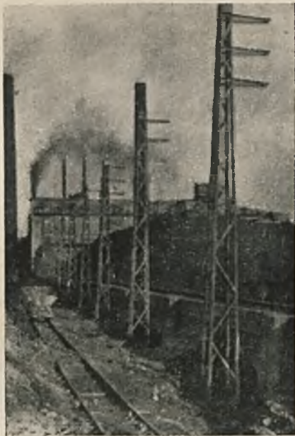
Rys. 7. Słupy spawane ze starych rur kotłowych.
