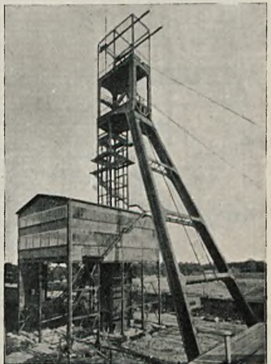
Rys. 19. Wieża nadszybowa w konstrukcji żelaznej w Miechowicach.
