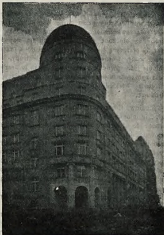
Rys. 1. Widok Nowego Gmachu P. K. O. przy ul. Świętokrzyskiej w Warszawie.
