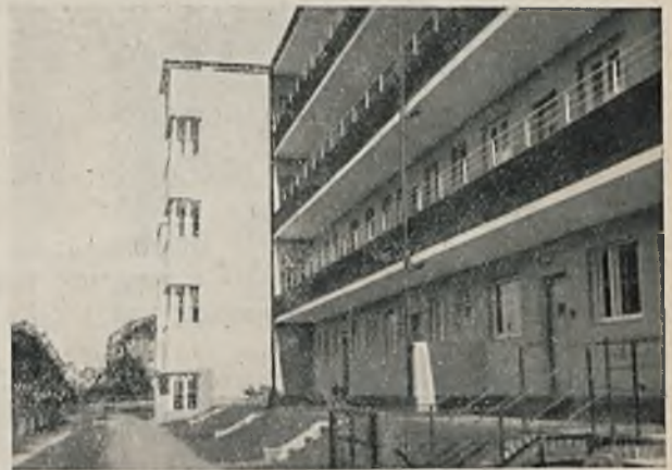
6) Widok gotowego budynku przy ul. Neuchatel w Berlinie.
