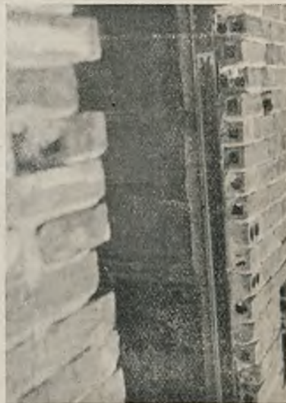
9) Przekrój ściany (zewnątrz cegła pusta wewnątrz heraklit).
