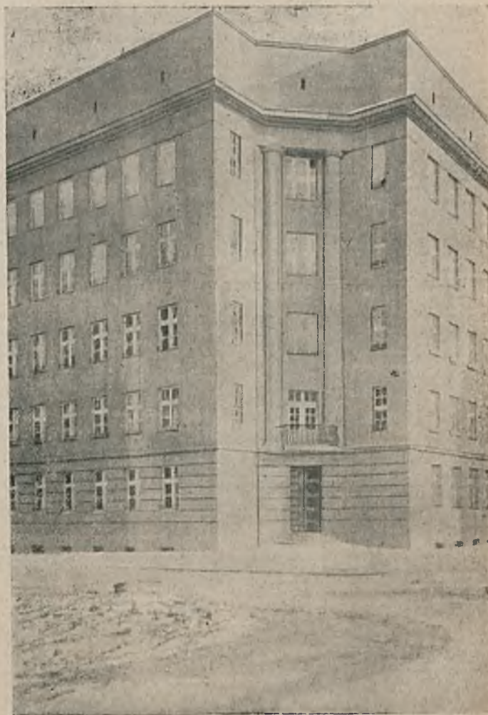
Dom mieszkalny w Katowicach przy ulicy róg Reymonta Ligonia, fasada od strony ulicy. Stan budowy z dnia 5 stycznia 1929 r.
