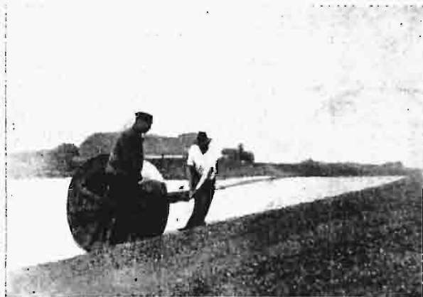
Ryc. 8. Asfaltowanie skarp śluzy Brienen. Walec ciągniemy prostopadle do skarp za pomocą windy ustawionej na brzegu dalej na lewo.
