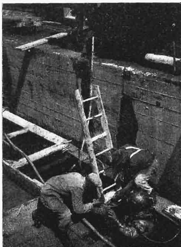
Rys. 37. Nurek biorący porcję szybkowiążącego cementu.
