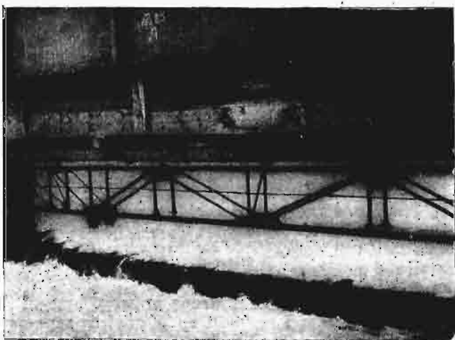
Ryc. 8 a. Zapuszczanie ścianki zabudowanej we wnękę od górnej wody.
