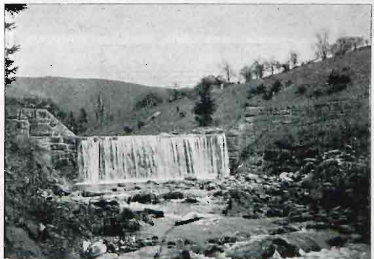
Ryc. 2. Zapora V (km 4.583).
