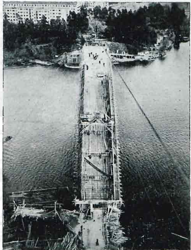
Ryc. 10. Widok ogólny w okresie układania wkładek łuku.
