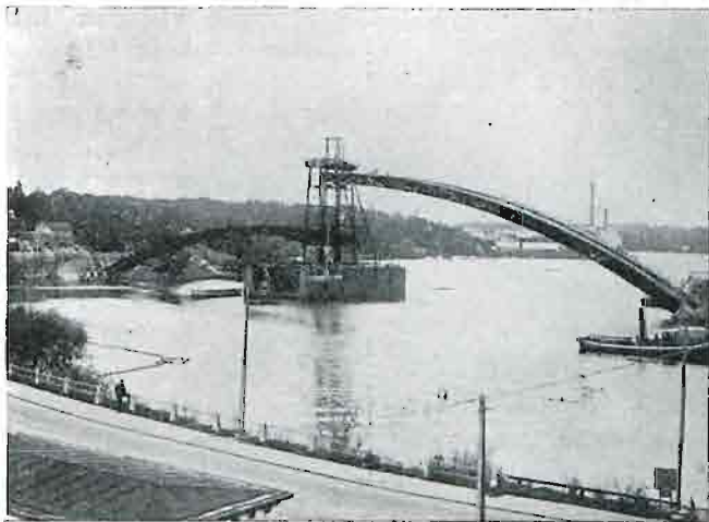
Ryc. 8. Zestawianie łuków stalowych rusztowania.
