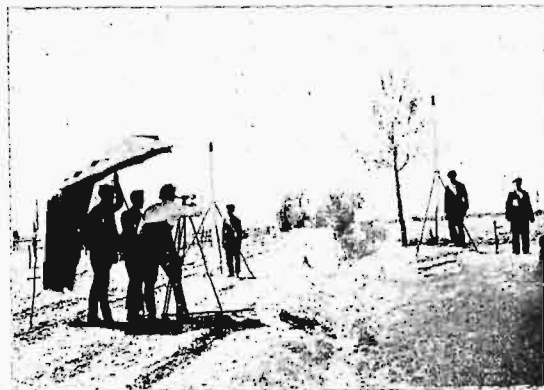
Ryc. 4. Partja pomiarowa w polu. Nawiazanie do reperu przy nivelacji precyzyjnej.
