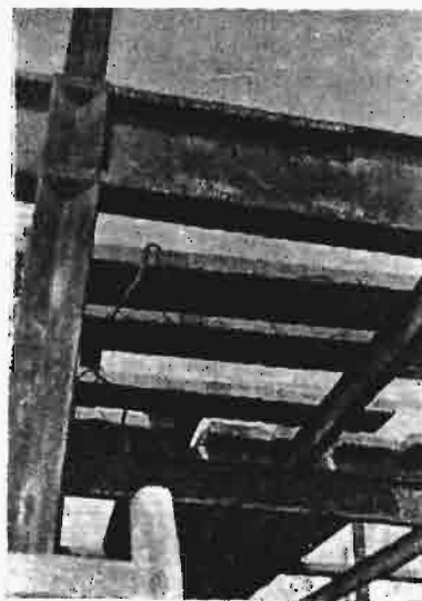
Ryc. 5. Wzmocnienie profilu przez wkładki wewnętrzne.
