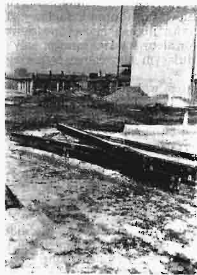
Ryc. 2. Podciągi wzmocnione nad słupami, gotowe do montażu.
