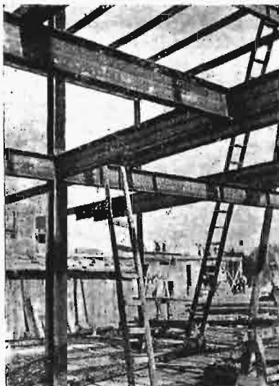
Ryc. 4. Węzły przy dwóch podciągach.
