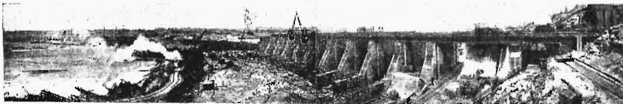
Ryc. 18. Ogólny widok robót betonowych przy lewym brzegu Dniepru (stan z końcem 1929 r.).
