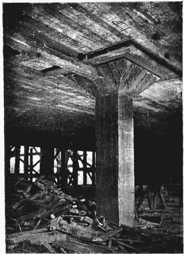
Ryc. 6 a. Widok na strop grzybkowy parteru magazynu kolejowego we Lwowie.
