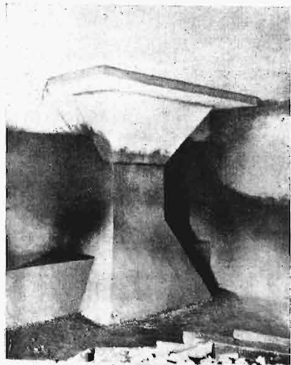
Ryc. 6 c. Słup stropu piwnicznego magazynu kolejowego we Lwowie.
