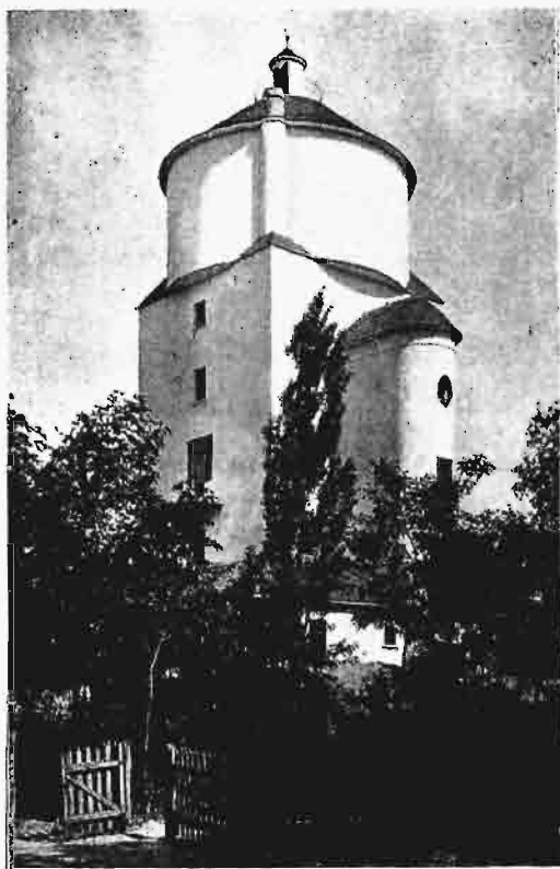
Ryc. 10 c. Wieża ciśnieniowa w Ciechocinku.
