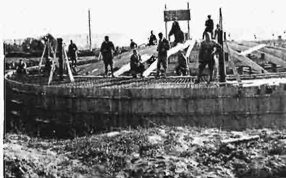
Ryc. 9 b. Układanie wkładek stropowych komory zewnętrznej zbiornika w Drohobyczu.
