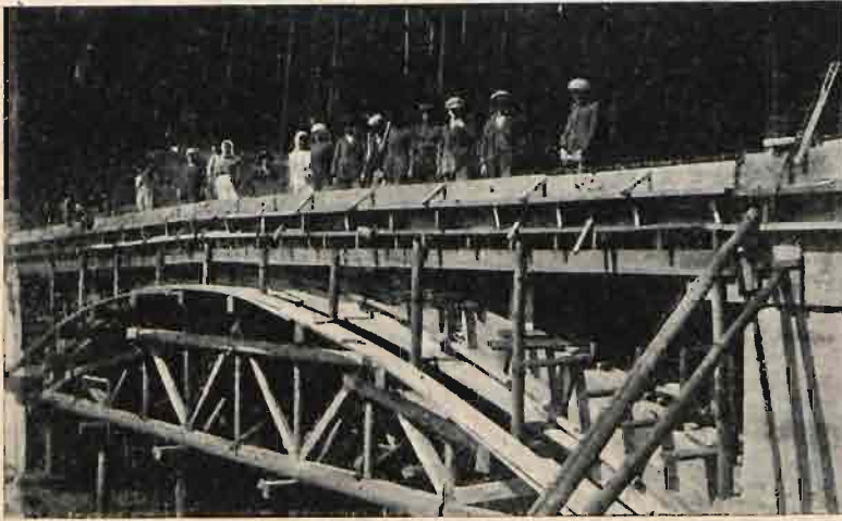
Rys. 5. Rusztowanie i deskowanie.
