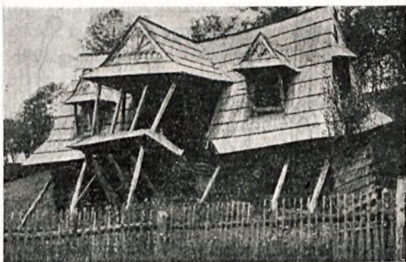
Zdjęcie zniszczonego domu z frontu.
