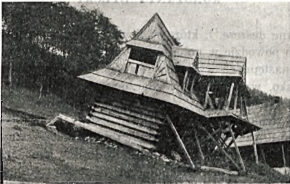
Dom w Zakopanem zrzucony z fundamentów przez zsuwę ziemną. Nr. 2.
