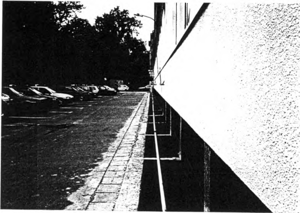
Rys.3.2.a. Widok ogólny stanowiska pomiarowego.
