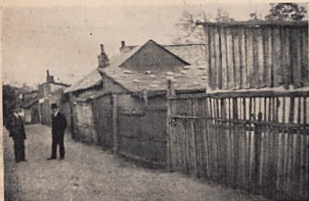
Fig. 3. Urbanistyczne prądy znajdują echo również wśród bezrobotnych. Oto „nowoczesna dzielnica“ w dzielnicy Grzywno we Włocławku. „Standaryzowana“ budowa szałasów i ziemianek pozwoliła zrzeszonym bezrobotnym taniej wznieść sobie dach nad głową.
