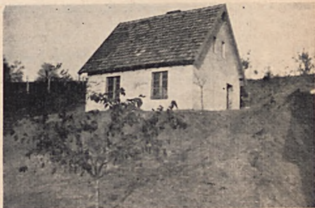
Fig. 5. Jeden z domków osiedla dla bezrobotnych w Chełmnie na Pomorzu. Osiedle w Chełmnie rozrzucone jest w bardzo malowniczej okolicy podmiejskiej.
