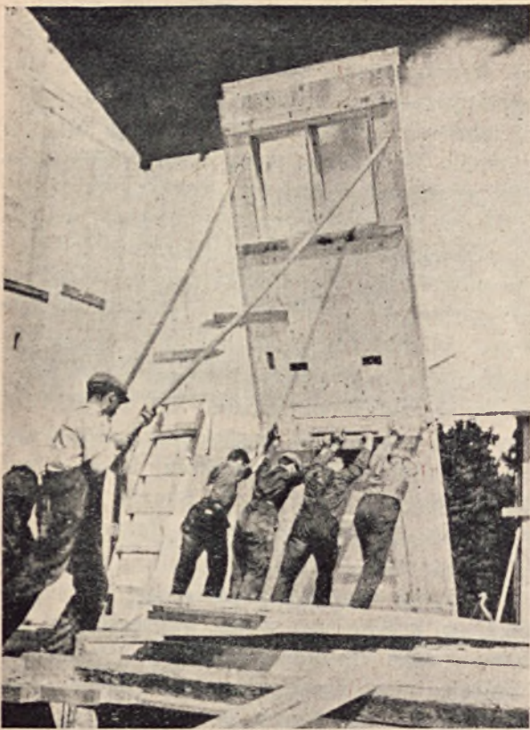
Montaż ścian domku dwukondygnacyjnego.
