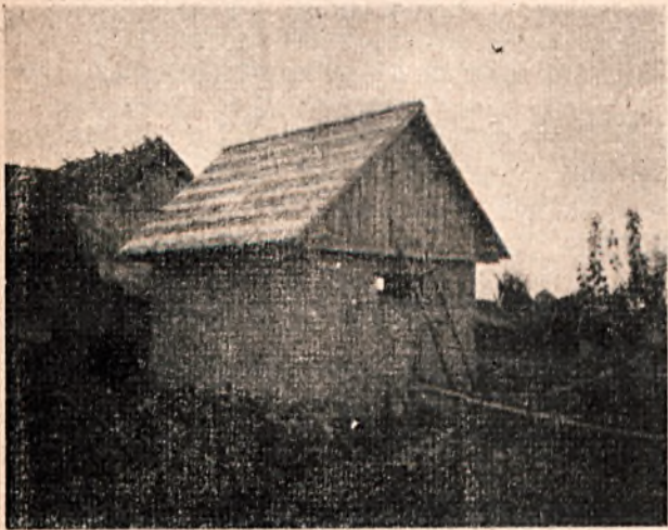
14. Kurnik, wykonany ze słomy moczonej w glinie (bez szkieletu), pokryty gontem — o kubaturze około 35 m sześć. (wydatek całkowity na budulec — bez robocizny — 35 zł).
