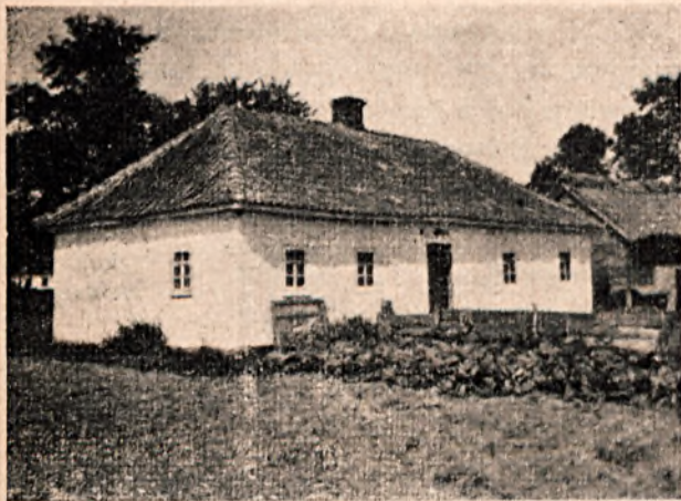
15. Budynek mieszkalny, wykonany ze słomy moczonej w glinie (bez szkieletu), otynkowany i pokryty dachówką.
