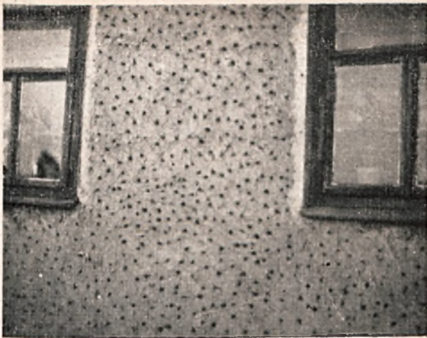
10. Powierzchnia ściany wykonanej sposobem glinobitym przygotowana pod wyprawę (m. Wiśniowiec na Wołyniu).
