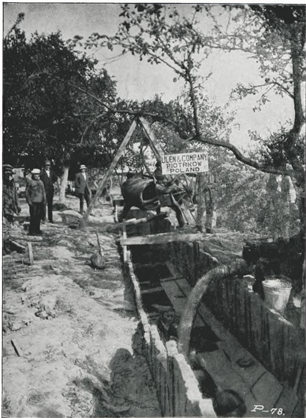
Fot. 5. Piotrków. Układanie rur kanałowych. (Str. 576).
