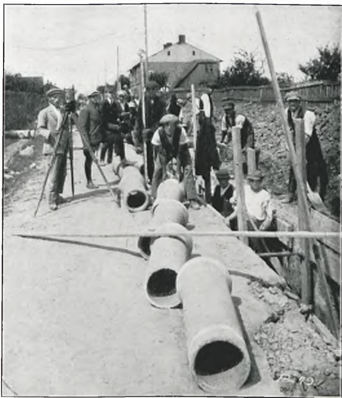
Fot. 4. Piotrków. Układanie rur kanałowych. (Str. 576).
