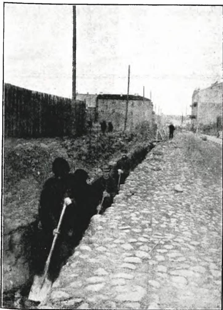
Fot. 1. Kanalizacja Radomia. Piaski, bocznicą 47. (str. 127).
