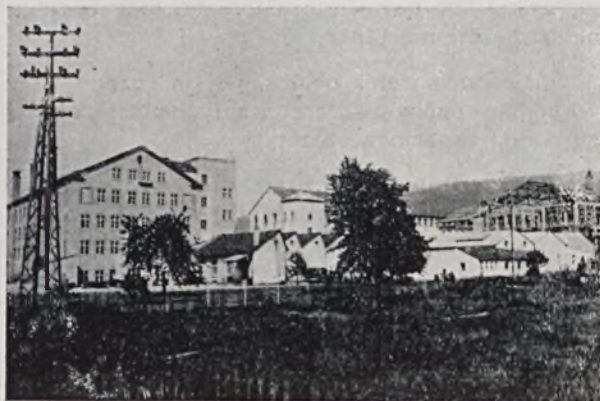
Widok ogólny fabryki.
