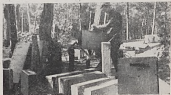
Ryc. 9. Obróbka płyt licowanych na miejscu budowy.
