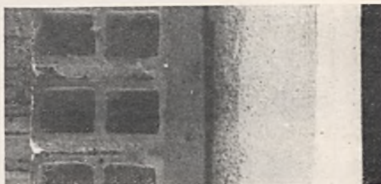
Ryc. 10. Ściana z okładziną w przekroju.
