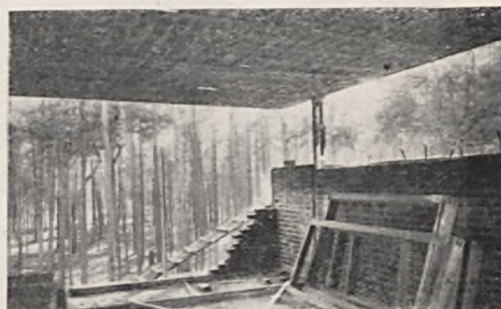
Ryc. 12. Ściana z okładziną. Widok od wewnątrz.
