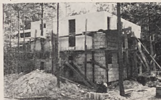
Ryc. 13. Ściany z okładziną. Widok podczas czyszczenia licówki. Bud. dr. B. w Konstancinie, H. i S. Syrkusowie. Konstrukcje wspólnie z prof. Hemplem.
