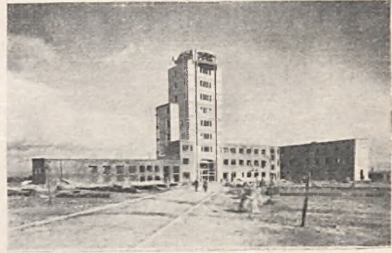
Ryc. 17. Ściany z płyt celolitowych bez użycia cegły. m 2 800. Izolacja dachów płaskich płytami i gruzem z celolitu m 2 1500. Wieża ciśnieniowa na Okęciu pod Warszawą. Arch. P. Czyżewski i arch. S. Widawski.
