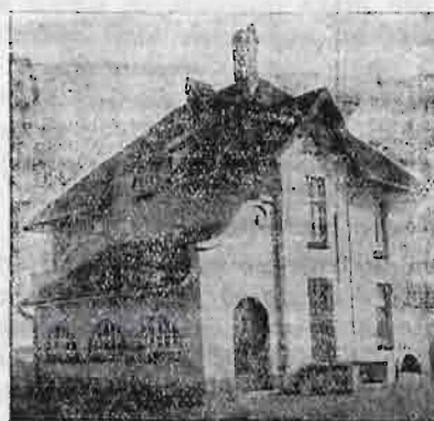
Rys. 6. Widok domu administracyjnego.
