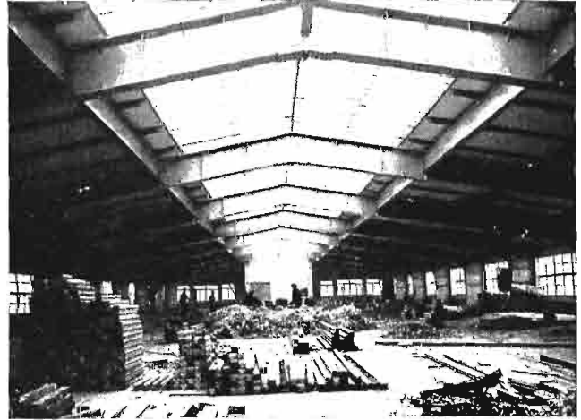
Rys. 23. Wnętrze traserni. Układanie podłogi traserskiej na piętrze
