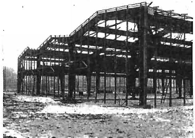
Rys. 4. Szkielet ściany szczytowej i rama skrajna R_I .
