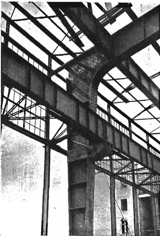
Rys. 8. Węzeł skrajny ramownicy i wspornik belek podsuwnicowych.
