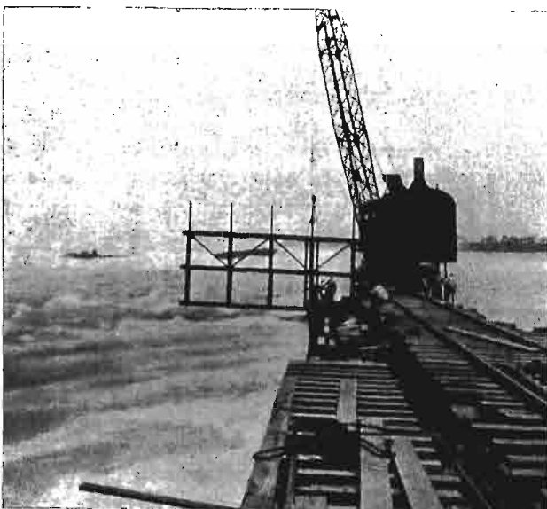
Rys. 2. Zakończenie mostu prowizorycznego w chwili zanurzenia rusztu odchylającego prąd.
