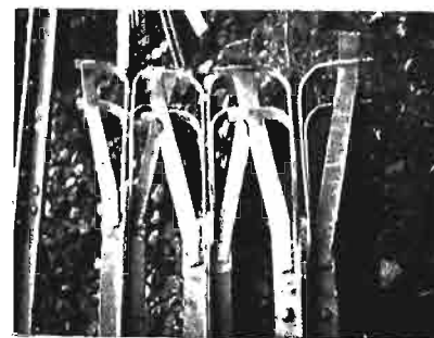
Rys. 3. Zakotwienie wieszaków w belkach mostu w Szeńsku.
