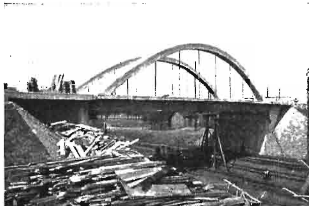
Rys. 3. Wiadukt nad torami w Kłomnicach (1939 r.).
