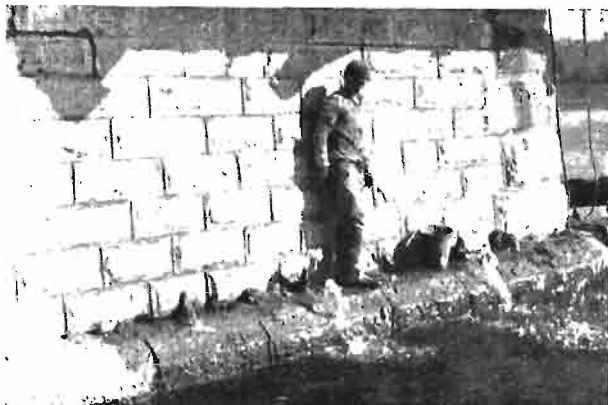
Rys. 6. Płukanie filaru Nr 9 (wąż doprowadzający wodę założony jest z drugiej strony filaru).
