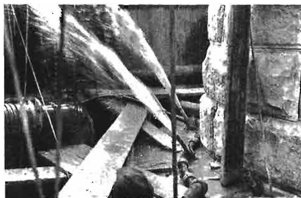
Rys. 8. Płukanie fundamentu filaru Nr 10
