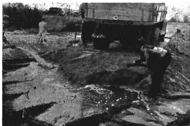
Rys. 3. Wypełnianie materaców piaskiem.
