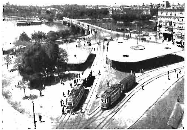
Rys. 4. Ogólny widok poczekalni, po ukończeniu budowy.
