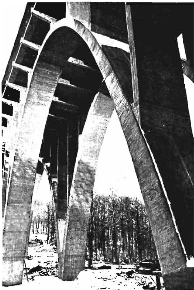
Rys. 13. Spód mostu w dolinie potoku Rohrbach.
