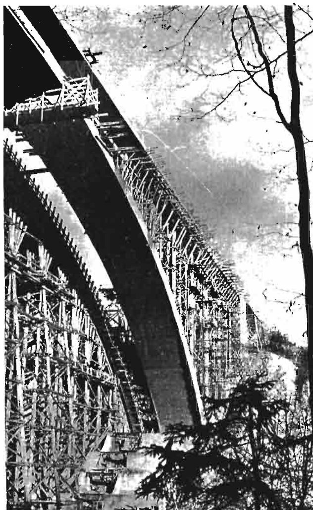
Rys. 19. Widok wykonanego jednego łuku mostu w dolinie Teufelstal po przesunięciu rusztowania.
