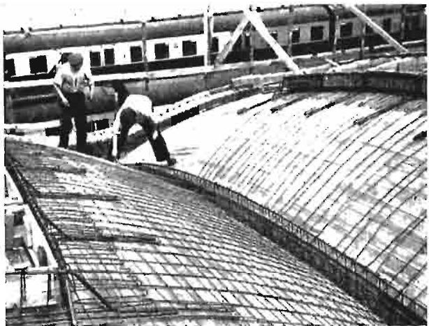
Rys. 19. Widok zbrojenia łupiny, żebra węglowiovego i żeber świetlikowych.
