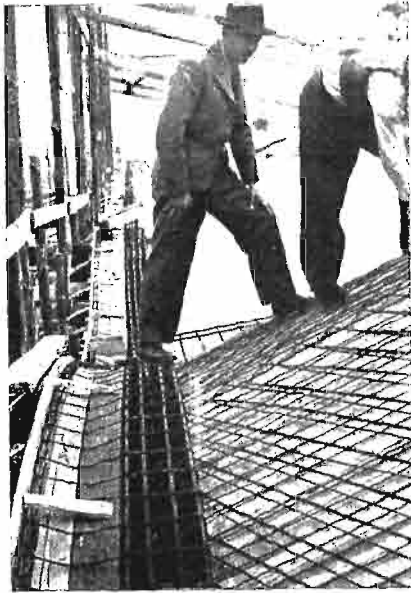
Rys. 14. Widok zbrojenia belki przeponowej, przyległej łupiny i gzymsu.
