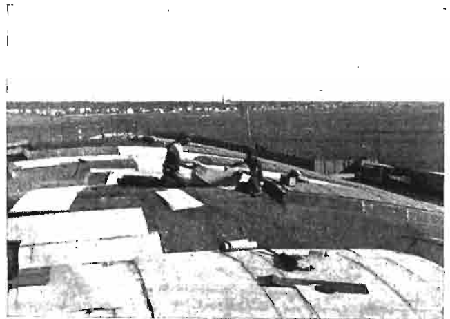
Rys. 24. Pokrywanie dachu papą.
