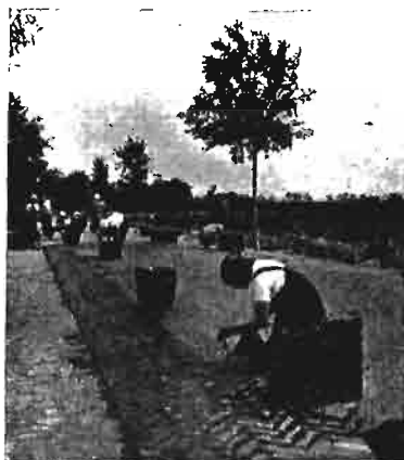
Zalanie bruku klinkierowego masą asfaltową „Polmin DB. III” (Grodków).
