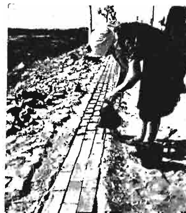
Zalanie spoin masą asfaltową „Polmin III” w opasce wykonanej z cegły klinkierowej.
