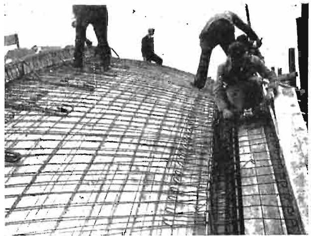
Rys. 18. Widok zbrojenia skrajnej bezułki.
