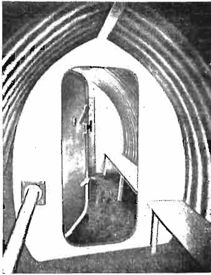
Rys. 22. Ścianka działowa i drzwi w schronie stalowym z blachy falistej.
