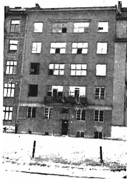
Fot. 22. Nowoczesna fasada.
