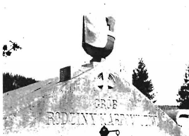
Fot. 3. Urna z piaskowca na grobowcu. Działanie wiatru i deszczu od strony zachodn.
