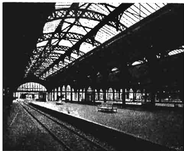
Rys. 2. Halle dworca głównego w Kopenhadze.
