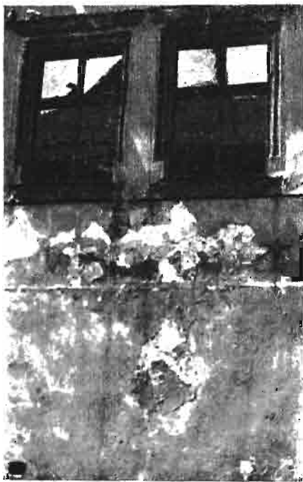
Fot. 8. Tworzenie się wykwitów na wyprawie.
