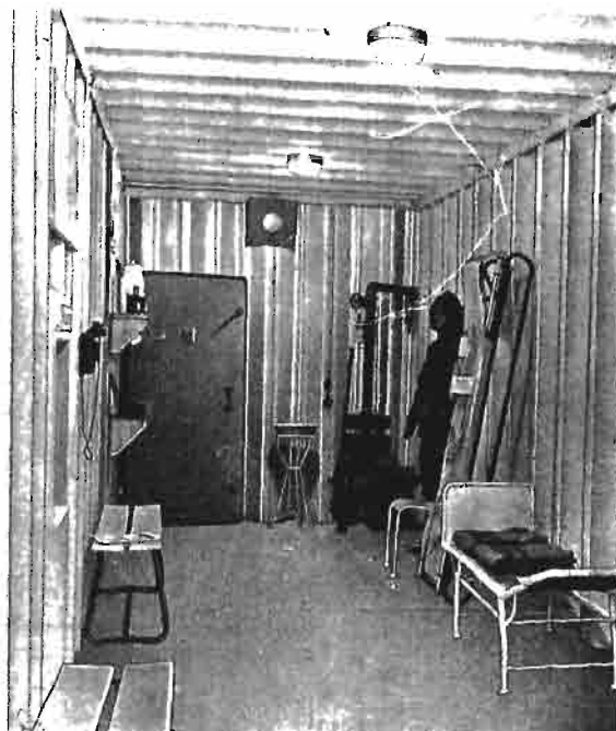
Rys. 29. Wnętrze schronu ze stalowych pali szpuntowych.
