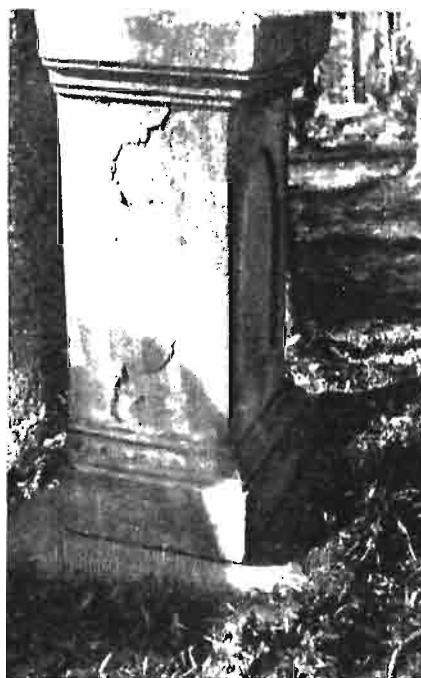
Fot. 2. Pomnik z piaskowca. Tworzenie się kory wietrzennej na powierzchni.
