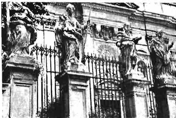
Fot. 2. Figury z piaskowca impregn. szkłem wodnym i olejami.
