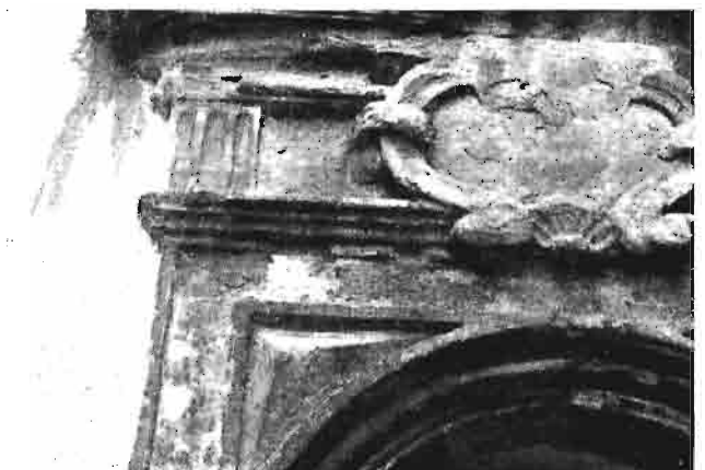
Fot. 4. Portal z piaskowca impregnow. pokostem i olejami.
