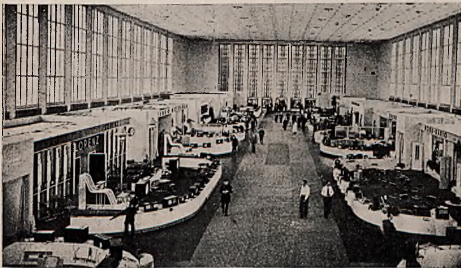
Ogólny widok hali odbiorników.
