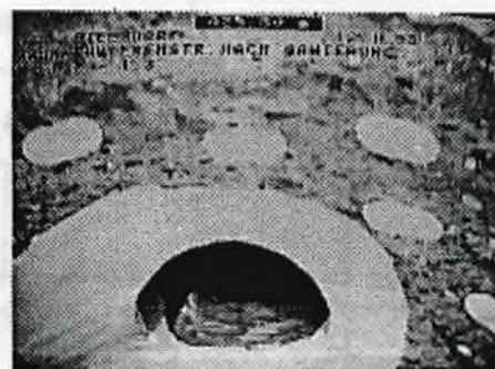
Rys. 18 Odgańlenie z widocznymi miejscami wtryskiwania.
