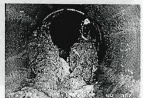
Rys.3 Nieszczelne złącze, infiltracja
