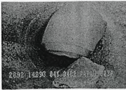
Rys. 1 Wystające odgałęzienie
