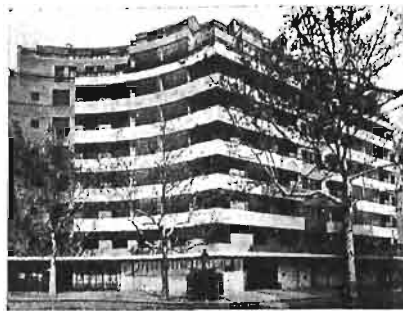
Kamienice mieszkalne w Paryżu. — Arch. C. i H. Delacroix. „L'Architecture d'A.” 7. 1935.
