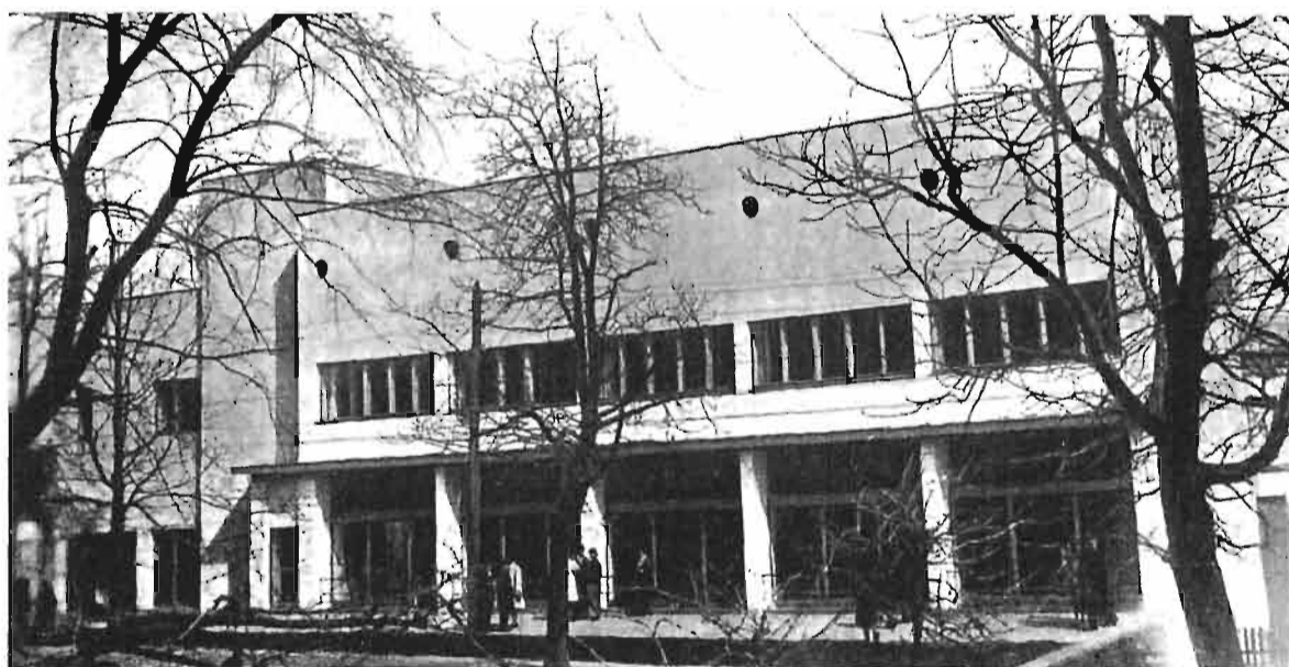
ARCH. EDWARD SEYDENBEUTEL (SARP) Dom wystawowy i biurowy F-my Chrysler. Bureaux et Exposition de la C-ie Chrysler. Show-rooms and Office of the Chrysler Company. Ausstellung und Bürohaus der Fir- ma Chrysler. Uffici ed esposizione della ditta Chrysler. Warszawa
