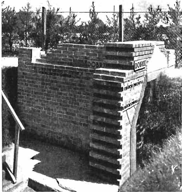
Dom w budowie i przykłady izolacji
