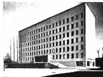
Ratusz w Kotka (Finlandja) — Arch. E. Huttunen. „Arkkitehti”
