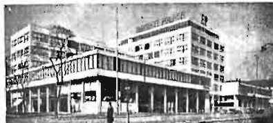
Biuro elektrowni w Pradze. — Arch. A. Bens i J. Kriz. „Stavba” 8.1935.
