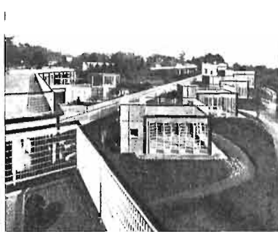
Szkoła na świeżym powietrzu w Surresnes p. Paryżem — Arch. E. Beaudouin i H. Lods.
