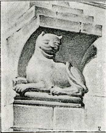
Ryc. 12. Nowy Korczyn. Kościół po-Franciszkański. Wspornik ściany szczytowej.
